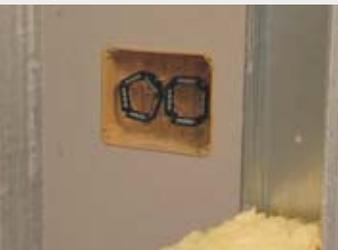
Установка коробки с помощью монтажного кольца
