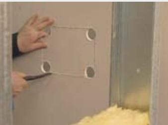
5. Установка коробки и проведение электроинсталляции.
