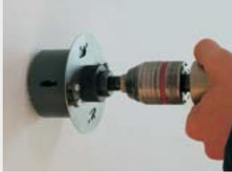
2. Установка монтажного кольца в гипсокартонные стены.
