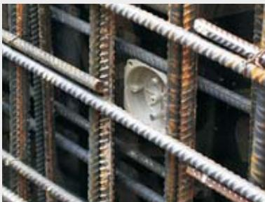
Смонтированные гибкие трубы в корпусе KBT.
