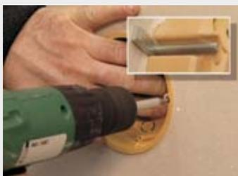
Монтаж многократной коробки в гипсокартонную перегородку
