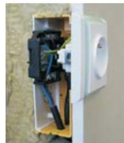
Примеры установки коробок в пустотелые стены
