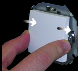
Установить на механизм клавишу и плотно прижать
