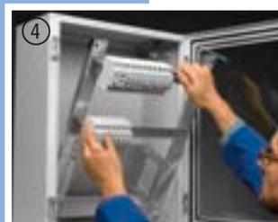
Монтаж и подключение производятся вне корпуса. По окончании этих работ несущая рама защелкивается в щитке на своем месте, а затем прикручивается.
