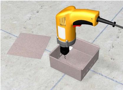
Das Blechgehäuse mit zwei Schrauben auf der Rohdecke befestigen.
