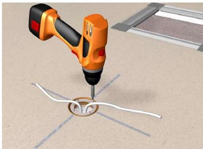
Anbohrauslass / Klemmring in das Bohrloch einsetzen und durch Anziehen der Schrauben verspannen.
