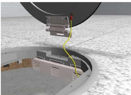
Deckelklappe nach oben herausziehen. Dabei Scharnierblech mit abwechselnder Kippbewegung nach links und rechts aus dem Sitz herausarbeiten.
