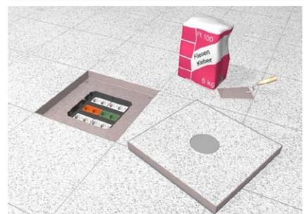
Kassettendeckel mit Bodenbelag belegen. Darauf achten, dass der Kleber gleichmäßig verteilt wird und der Belag plan im Kassettendeckel aufliegt, ansonsten besteht Bruchgefahr des Belages.
