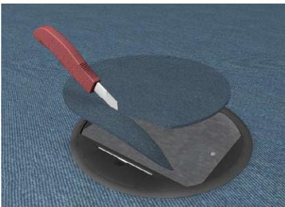
Bodenbelag passgenau ausschneiden und in den Deckel der Versorgungseinheit einkleben.
