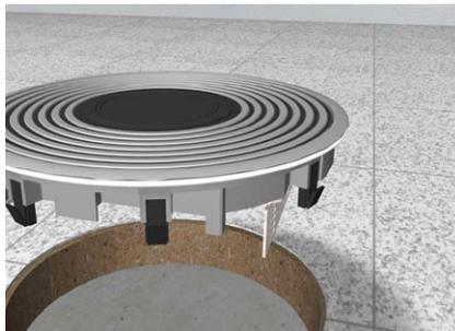
Abstand des Befestigungsset in Bezug auf die jeweilige Bodenaufbauhöhe prüfen und Versorgungseinheit in die Montageöffnung eindrücken. Sollte sie sich nicht leichtgängig drücken lassen, Schrauben des Befestigungsset weiter herauschrauben, bis Befestigungsset unter die Bodenplatte greift.
