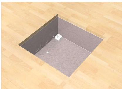
Bodenbelag verlegen. Einbauöffnung von 200 x 200 mm offen lassen.
