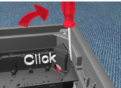
Die Lasche des Gerätebechers mit Hilfe des Schraubendrehers in der gewünschte Rasthöhe einrasten. Die Rastnase muss hörbar einrasten.
