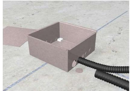
Benötigte Ausstanzungen für Installationsrohre ausbrechen und Installationsrohre einführen. Ausstanzungen für M25 bzw. für M20 Größe geeignet.
