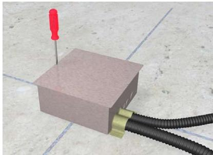
Schutzdeckel mit zwei Schrauben auf dem Blechgehäuse montieren. Dieser dient als Schutz beim Verlegen des Estrichs.
