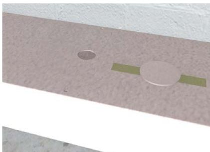
Auf den Blinddeckeln mit Montageöffnung (MES GBZ / MAS GBZ, separat zu bestellen) des jeweiligen Kanalsystems sind werkseitig Schutzdeckel aufgeklebt, die unmittelbar vor der Bodenbelagverlegung entfernt werden müssen.
