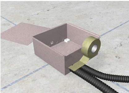
Das Blechgehäuse zum Schutz gegen Eindringen von Estrich mit Klebeband abdichten.
