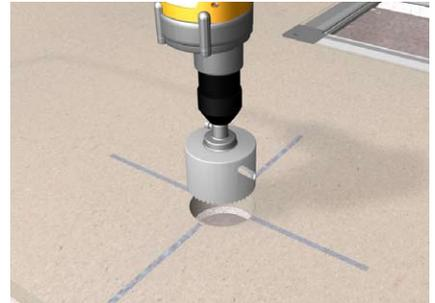
Unterflurkanal mit Sägekranzaufnahme aufsägen.
