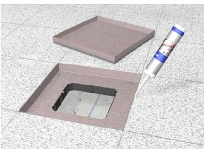
Dehnfuge um den Kassettenrahmen mit einem elastischen Fugenmittel versiegeln.
