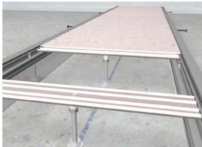
Nivellierstifte in Gewindehülse eindrehen. Kontermutter SM M8 und Dämmhalter ZE-D auf Nivellierstift schrauben. Traverse mit Nivellierstift leicht gegen die Rohdecke verspannen. Nivellierstift mit Kontermutter SM M8 unter Nivellierhülse festsetzen.
