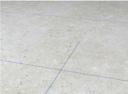
Kanalverlauf gemäß Verlegeplan auf der Rohdecke markieren, z.B. mit Kreide oder Schnur. Tatsächliche Nivellierhöhen auf der Rohdecke überprüfen.
