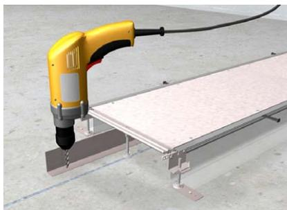
Trennwand ZES... direkt auf der Rohdecke andübeln. Bohrungen in Trennwand bauseitig herstellen. Trennwand durch mitgelieferte Erdungsklemmen zum Aufschlagen in die Erdungsmaßnahme mit einbeziehen.
