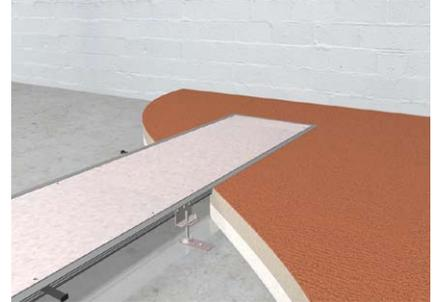
Estrich bis Oberkante der Kanalprofile verlegen. Kanalblinddeckel können auch mit Bodenbelag beklebt werden.
