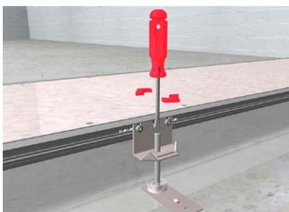
Oberkante Kanalseitenprofil auf erforderliche Höhe nivellieren.
