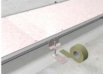
Fugen des Kanalsystems gegen Eindringen von Estrichmassen sicher abdichten.
