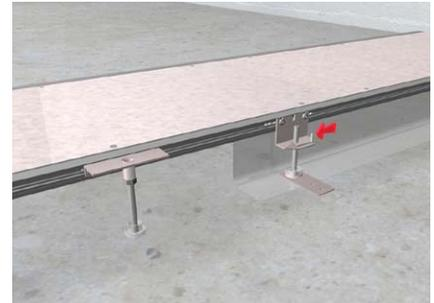
Vorhandene Nivellierschelle am Kanal vom Kanalverbinder lösen. Beide Bauteile zum Einbauort der Anschlussdose verschieben.
