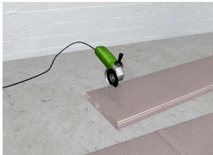
Bei Bedarf können die Unterflurkanäle auf die passende Länge geschnitten werden. Scharfe Kanten müssen anschließend entgratet werden.
