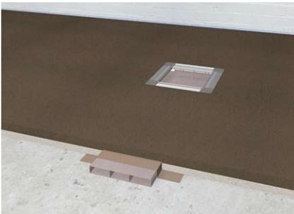
Beim Heißestrich/Gussasphalt werden Temperaturen von ca. 280 Grad Celsius erreicht. Aus diesem Grund müssen die Kanäle und Zug- und Abzweigdosen mit bitumierter Wellpappe abgedeckt und isoliert werden. Die Kabelverlegung darf wegen den hohen Temperaturen erst nach vollständigem Auskühlen des Heißestrichs erfolgen.
