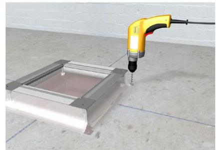
Bei der Zug- und Abzweigdose UDB... oder UDS3 alle vier Ecken vom Bodenblech an der Rohdecke andübeln. Bohrungen von 6,5 mm sind in jeder Ecke vorhanden.
