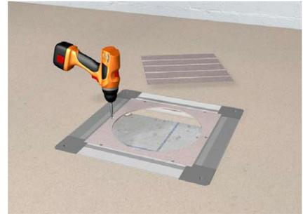
Montageschutzdeckel erst direkt vor der Bodenbelagverlegung entfernen und gegen einen Montagedeckel austauschen. Mit Schrauben im Dosenrahmen oder im Aufstockrahmen befestigen.
