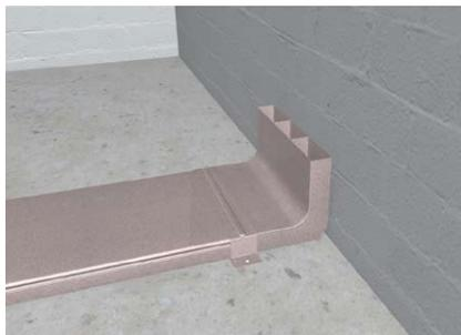
Krümmer als Wandanschluss mit Befestigungsschelle an den Unterflurkanal anschließen.
