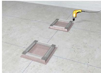
Zug- und Abzweigdosen gemäß Verlegeplan auf der Rohdecke verlegen und befestigen.
