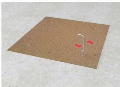
Nach dem Gießen der Rohdecke Montageschutzdeckel von der Bodendose entfernen. Dazu vier Innensechskantschrauben aus der Spanplatte herausdrehen und Spanplatte entfernen.
